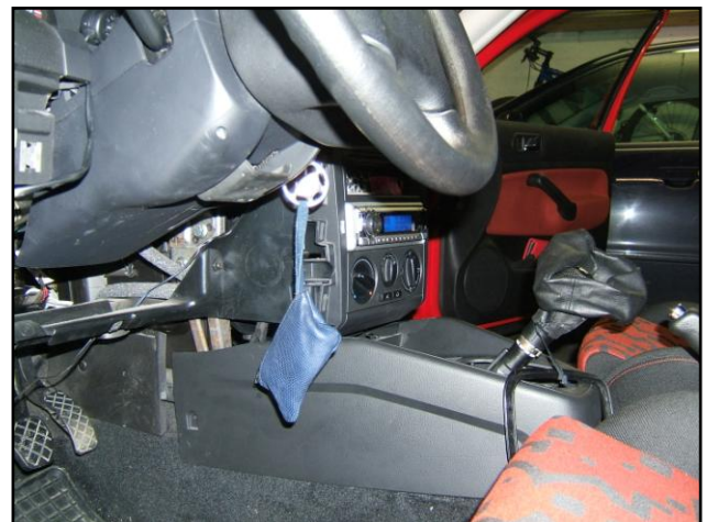
Abb. 27 So sollte die Mittelkonsole zum weiteren Einbau aussehen
